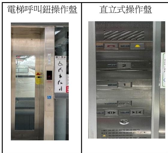
圖二 無障礙電梯呼叫鈕操作盤和直立式操作盤
